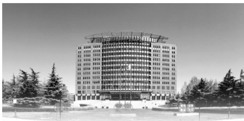
北京工业大学科学楼 图片由北京工业大学提供
